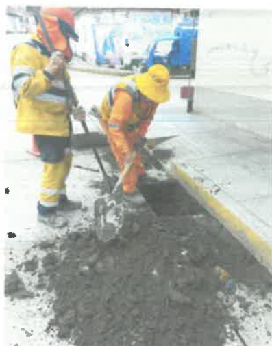
ILUSTRACIÓN N° 69 Limpieza de Canales de Drenaje
