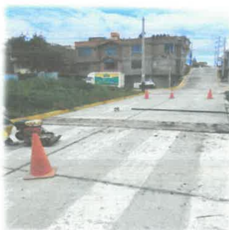
ILUSTRACIÓN N° 70 Construcción de un reductor de velocidad
