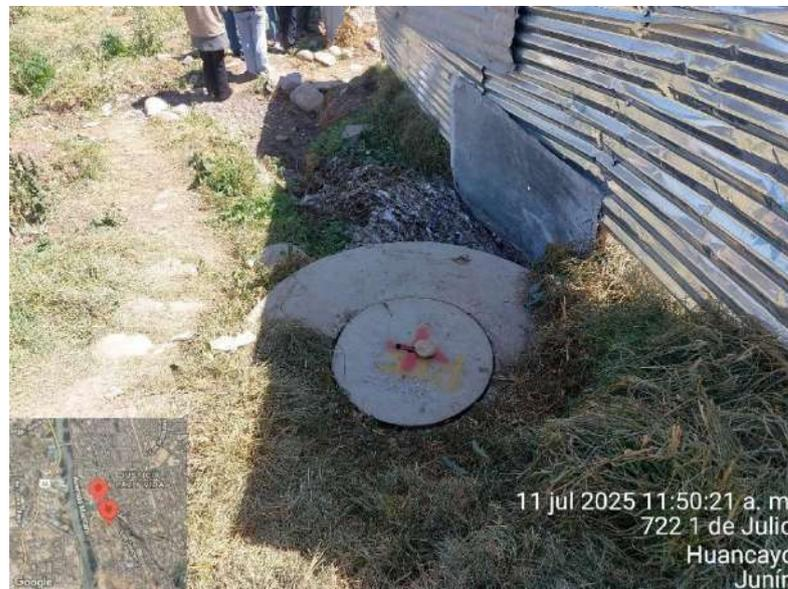
**FOTOGRAFÍA N° 2 BUZONES DE ALCANTARILLADO**
