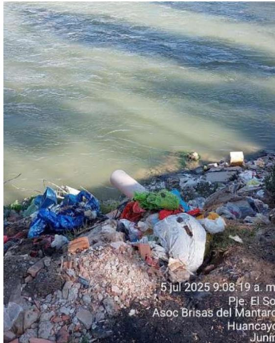
**FOTOGRAFÍA N° 3 TUBERÍA DE DESAGÜE CON DESCARGA DIRECTA AL RÍO MANTARO**
