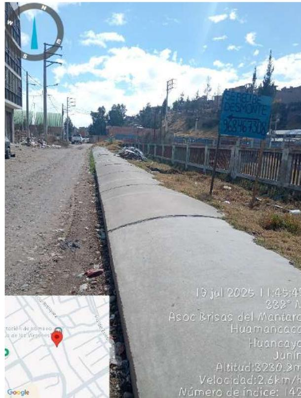
**FOTOGRAFÍA N° 32 CANAL PLUVIAL AGUA DE LAS VIRGENES**
